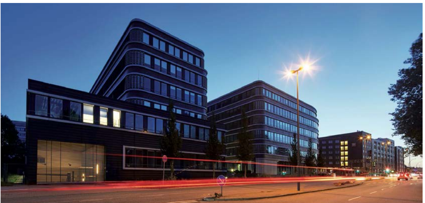
Hammer Straße 30-34 | Hamburg
