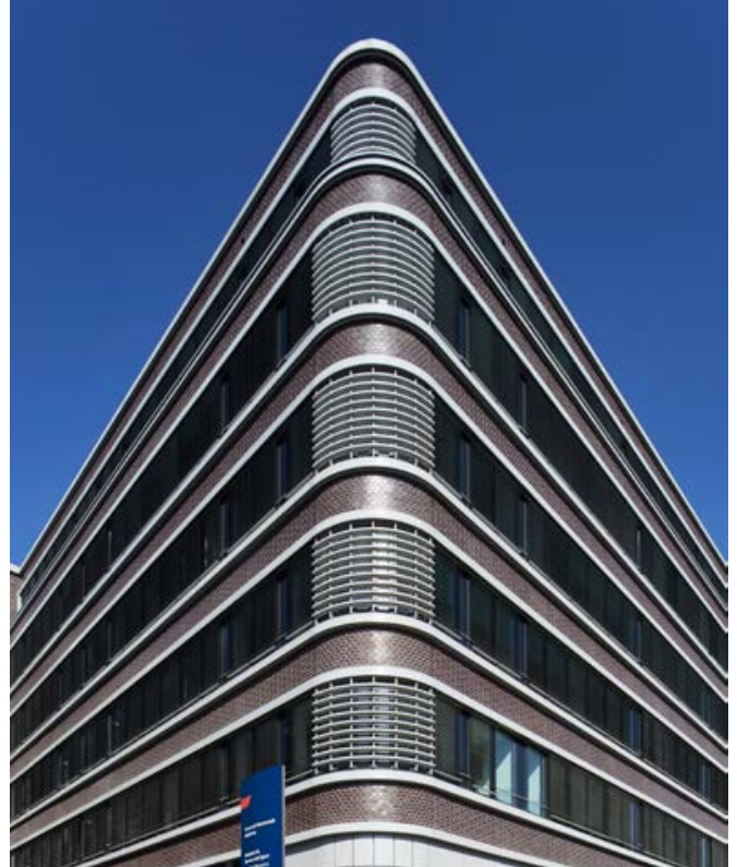
● Hammer Straße, Hamburg
